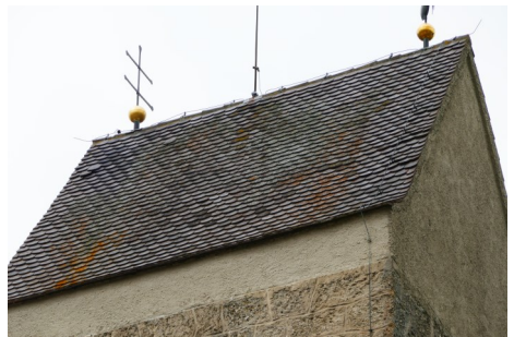
Bestehende Dacheindeckung des Kirchturms von 1958, östliche Seite
